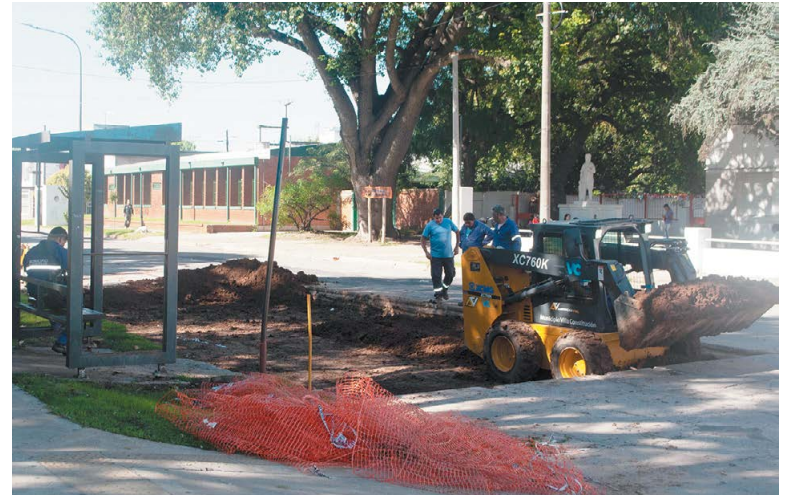
Esta semana comenzaron los trabajos en Dorrego y Acevedo.
