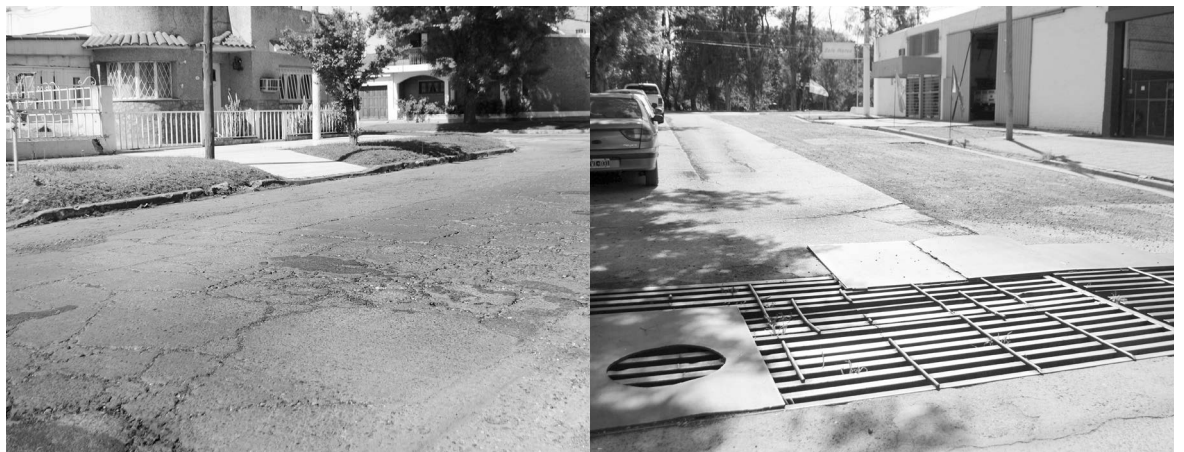
La calle sufrió un importante deterioro durante el desvío del tránsito de las Dos Rutas.
